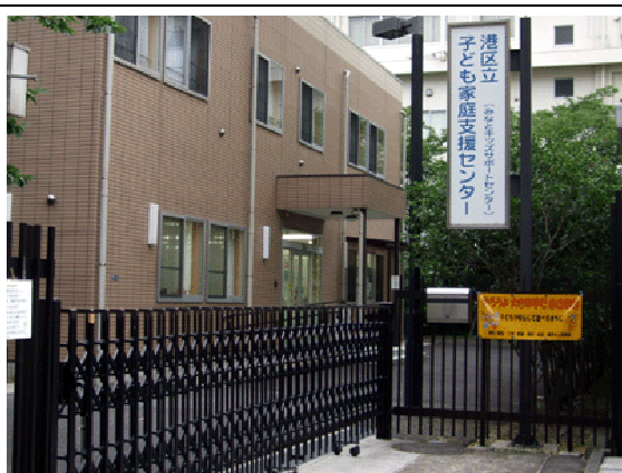
港区立子ども家庭支援センター入口 (伸縮門扉引戸)
